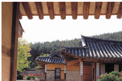
기와지붕 Hanok, Tiled( giwa ) Roof
